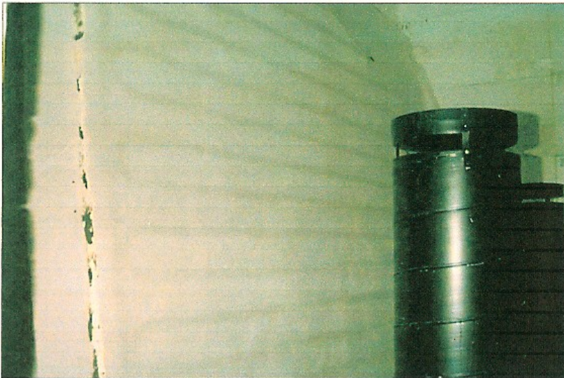
Kühlwand (Schamotte-Steine) mit Verbundrohr (16 x 2mm), Fa. Ingenieurbüro Berghammer., Wand mit eingelegtem PE/Al/Pe-Rohrregister (16 x 2); Tlg: 155mm, Rohre direkt in Wandmaterial eingebettet, stoffschlüssige Verbindung
